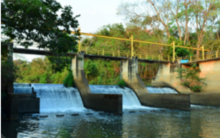
Rio Meia Ponte, de captação de água para Goiânia, está com a vazão em 2.444,6, considerado nível crítico 3
