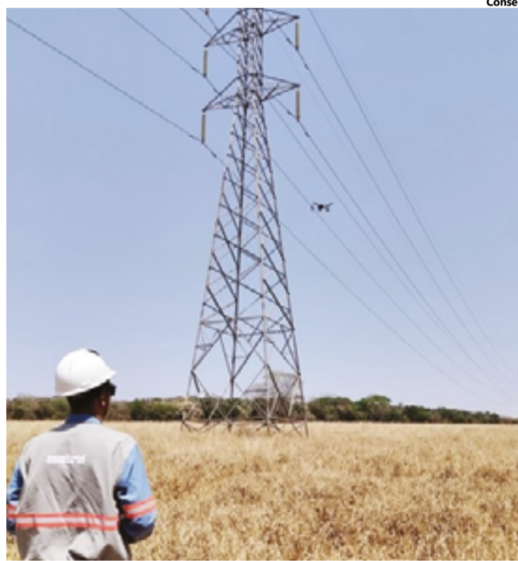
Equatorial usa a tecnologia nos ares como aliada para detectar defeitos
